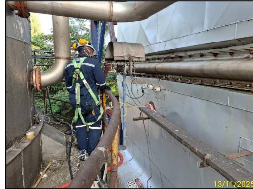
(3) ปล่อง Boiler (Inlet): Soot Blow
